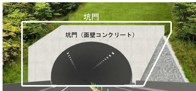
図 1-3 点検対象箇所（トンネル坑口部）
