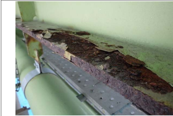
① 部材 上部構造 主桁 判定区分 II
