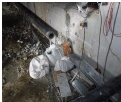
(滞水採取状況)
