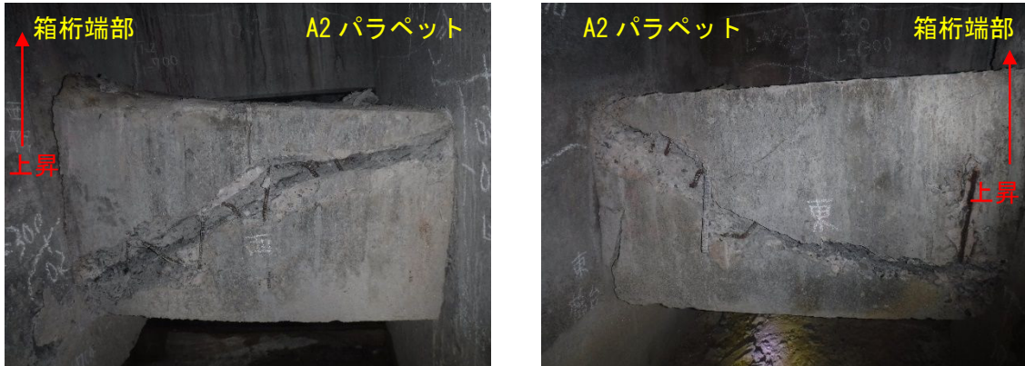
図 4.41 水平ロッカー脊全景（左：西側、右：東側）
