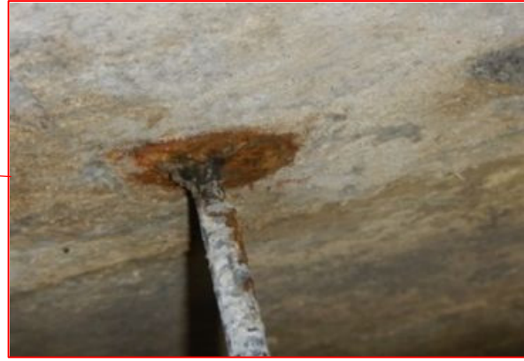
図 4.38 A2 橋台上部工突起部背面差し筋の腐食状況
