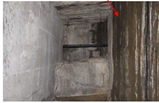
(伸縮装置からの浸水状況)
