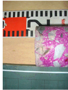
写真2. 中性化深さ測定結果状況 C-D-H点付近写真
