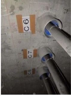
②PC貫通孔状況
