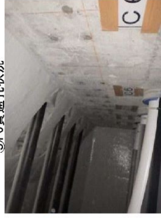
④PC貫通孔周辺状況
