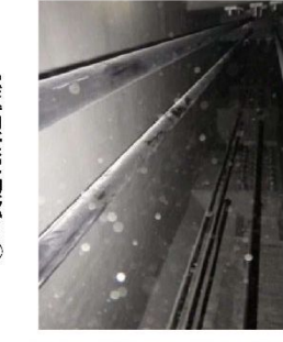
⑤PC鋼材、上面状況
