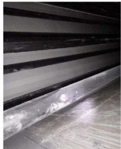
⑩PC鋼材状況
