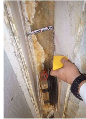
③ 橋座部状況
