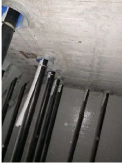
①A2部壁面状況
