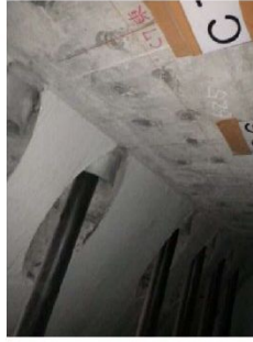
③PC貫通孔状況
