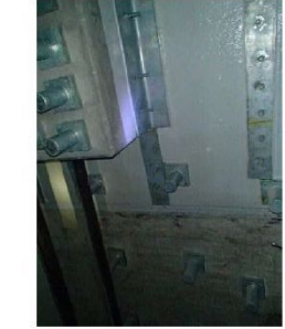
⑥PC定着部、側面状況
