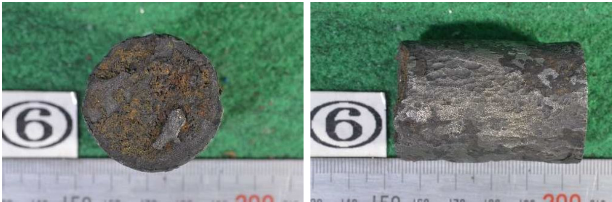
(a)破断面 (b)側面 写真-23 サンプル No.6 下部の破断面近傍の外観写真 (錆除去後)
