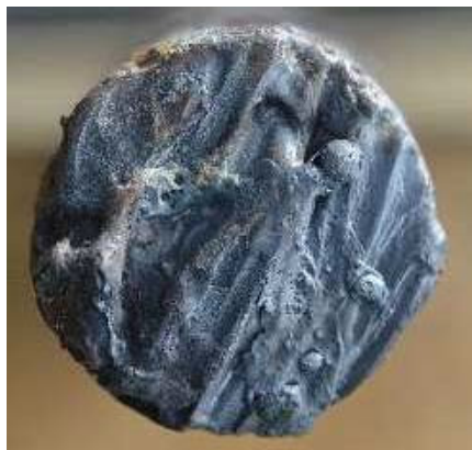
(a)切断面（ガス溶断）
