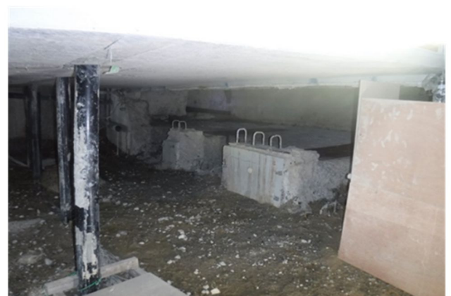
図3 桁裏土砂撤去の流れ
