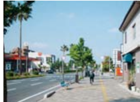
電線地中化後
