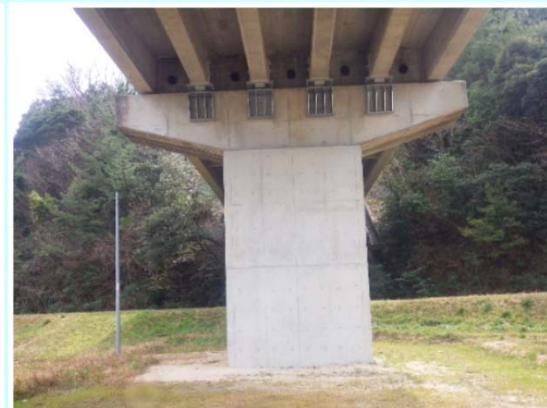
国道315号 須佐跨線橋 萩市 平成30年3月完成
