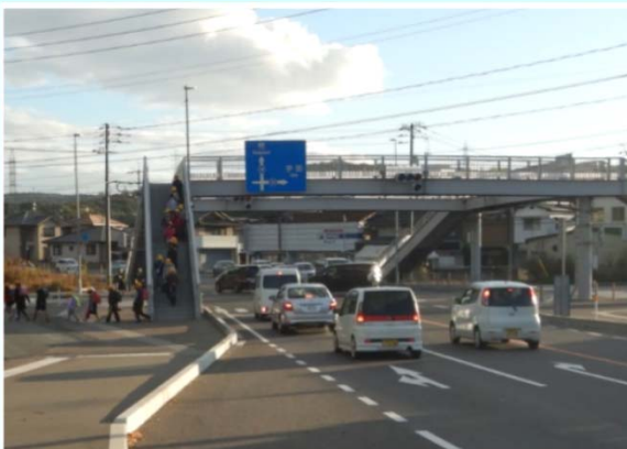
県道宇部船木線 宇部市 平成30年8月完成
