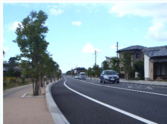
県道萩城趾線 萩市 (都市計画道路今魚店金谷線) 平成30年3月完成
