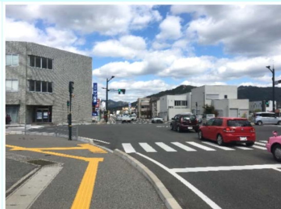
県道三田尻港徳地線 防府市 (都市計画道路戎町迫戸線) 平成30年3月完成
