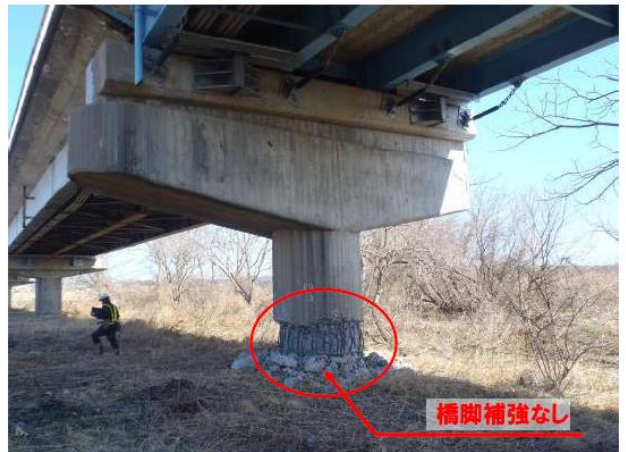
県道 (観測震度:震度5弱)
