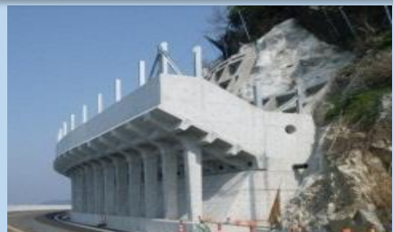
国道191号(下関市津波敷)
