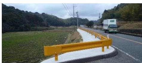
路肩コンクリートによる防草対策
