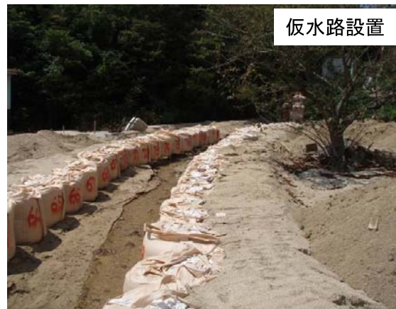
写真-4 応急対策工事の実施状況 (山田上川)
