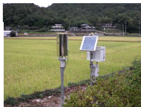
写真-2 雨量計設置状況 防府市十七谷(鈴屋)
