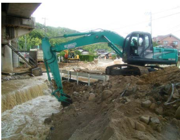
図-14 剣川の河道埋塞状況と埋塞土砂掘削状況
