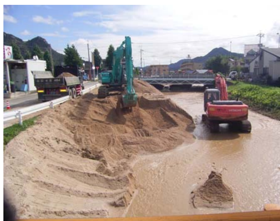
図-14 剣川の河道埋塞状況と埋塞土砂掘削状況
