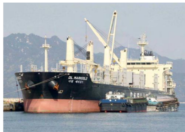
室の木岸壁 (-12m) の荷役状況
