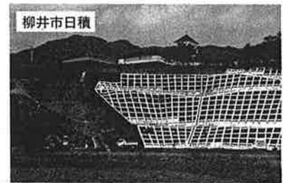
急傾斜地の崩壊による災害から人命を保護するため、法枠工を整備する。
