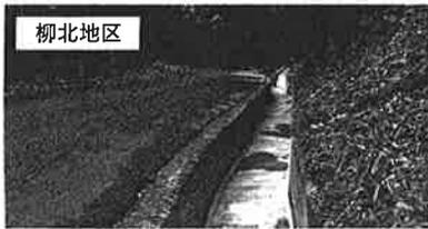
柳井市黒杭の長溝水路は、畑の池ため池から新庄地域へ通じる重要な農業用水路であるが、老朽化が著しいため、補修工事を行い、用水確保と用水管理の軽減を図る。
