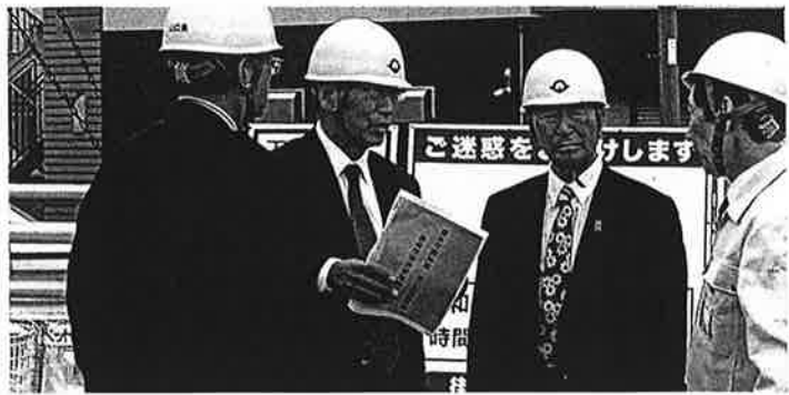
新山口駅長谷線工事現場
