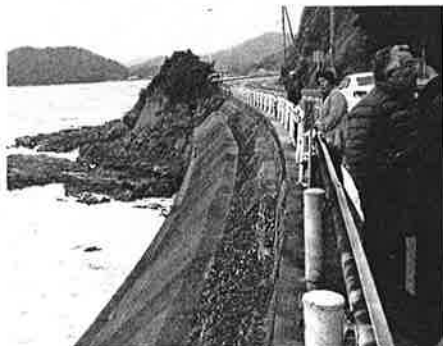
一般国道191号七曲りの危険箇所をバトロールする!
