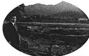
▲浚渫現場へ直行(長門)
