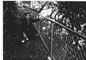
ため池の防護柵設置(上宇部)
