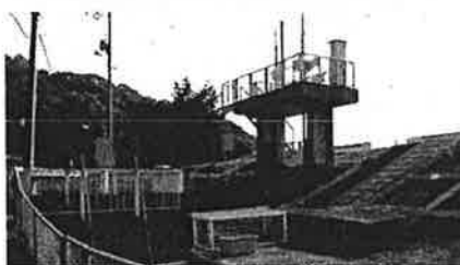
雨水ポンプの改修完了（宇部市浜田町）
