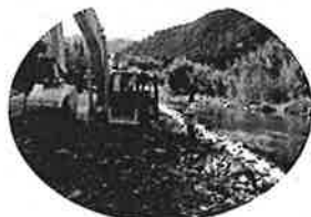
▲河川改修現場(秋市)
