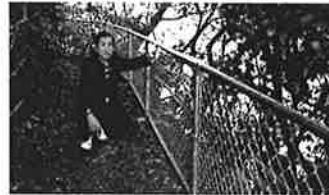
ため池の防護柵設置(上宇部)
