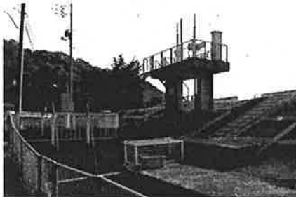
雨水ポンプの改修完了 (宇部市浜田町)
