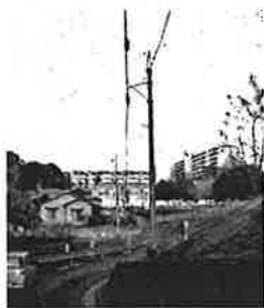
防犯灯の設置
