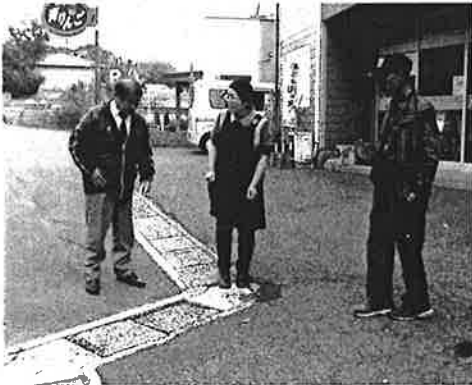
側溝改修の市民相談現場（宇部市上宇部）
