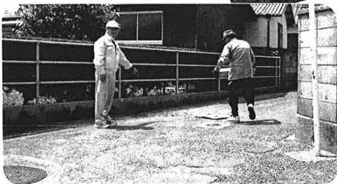
通学道路改修の市民相談現場（宇部市上宇部）
