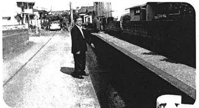
側溝の防護柵の設置要望（宇部市）
