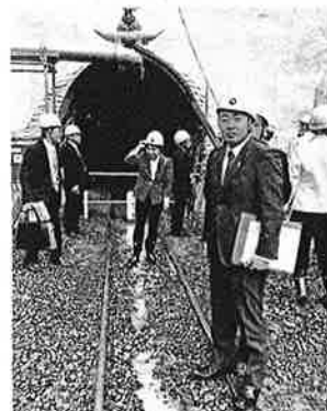
■工業用水道工事現場を視察
