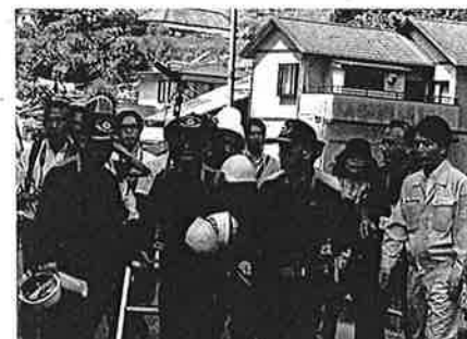
平成30年7月13日、豪雨災害で甚大な被害を受けた周東町獅越地区を視察しました。
