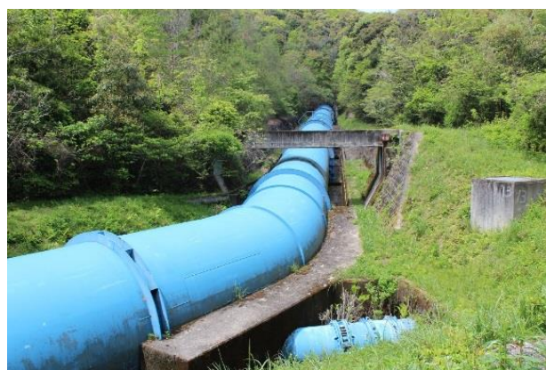
厚東川工業用水道φ4,000 連絡隧道
