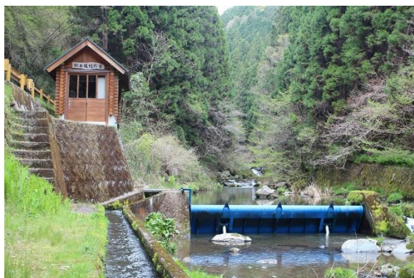
本郷川発電所取水堰
