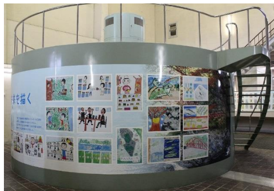
新阿武川発電所
