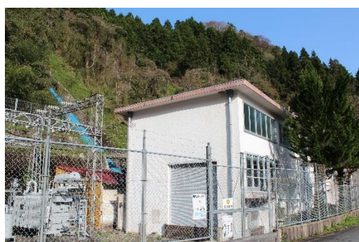
佐波川発電所
