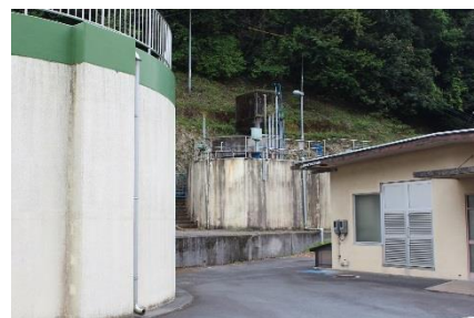
小瀬川工業用水道送水井・ポンプ場
