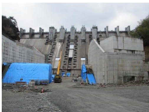
平瀬発電所建設事業
