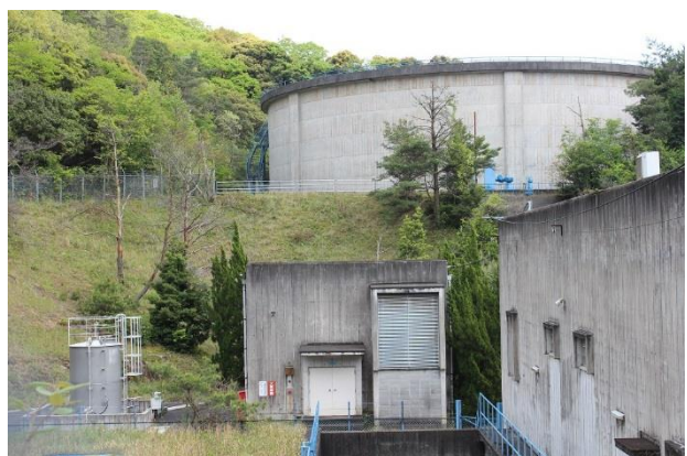
有帆ポンプ場
