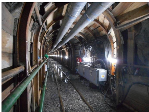
島田川工業用水道建設事業
