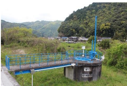
小瀬川工業用水道接合井
