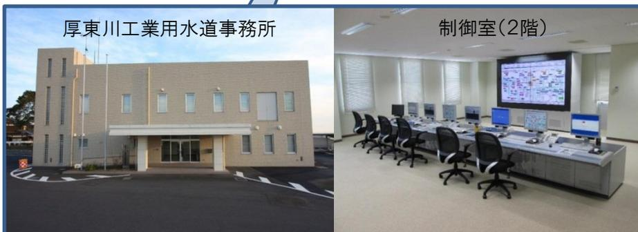
宇部丸山発電所は、宇部市にある厚東川工業用水道事務所で監視しています。制御室で発電所の運転停止、流量調節等の操作や、機器の状態を監視しています。
