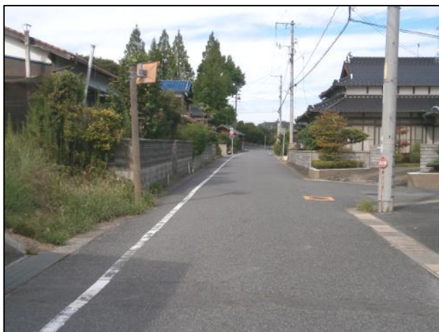
ブロック塀など倒壊物に注意
