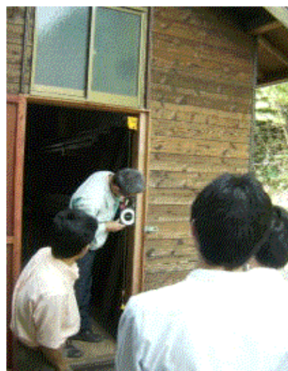
建物の鉛直度調査
