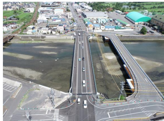
【橋梁の耐震補強】 県道徳山下松線（荒神大橋(下松市大字末武中)）
