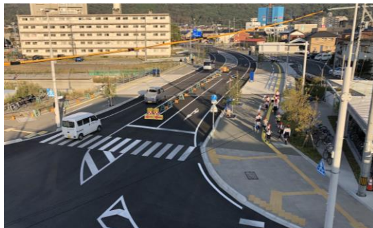
【現道拡幅】 県道新山口停車場長谷線
