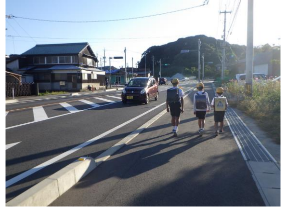
【歩道整備】 県道粟野二見線（下関市豊北町大字滝部）
