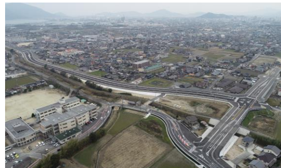
【バイパス】 県道防府環状線
