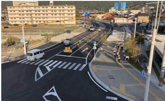
【現道拡幅】 県道新山口停車場長谷線
