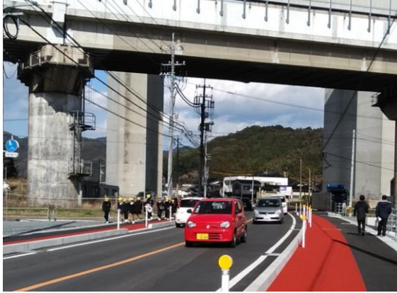
【自歩道整備】 県道新南陽津和野線（周南市大字上下）
