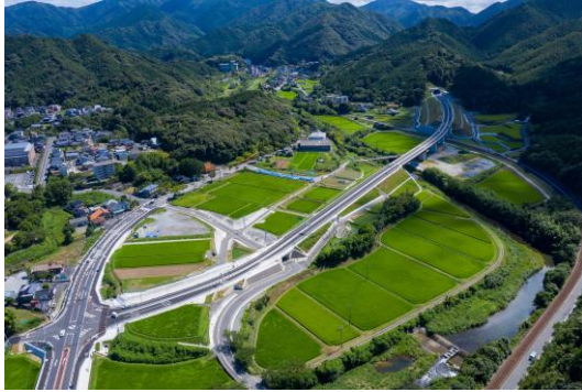
【高規格道路】 国道 491 号長門・俵山道路
