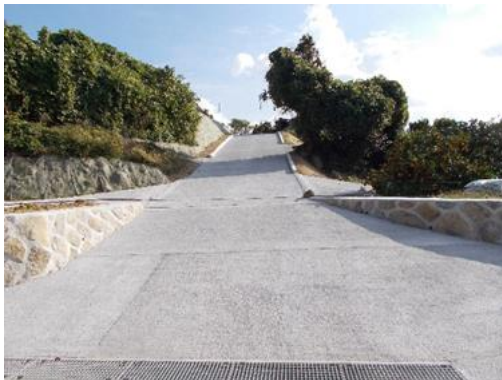
完成した農道
