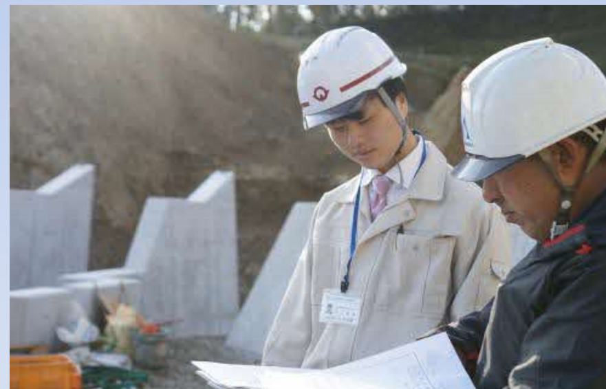
工事の現場監督
