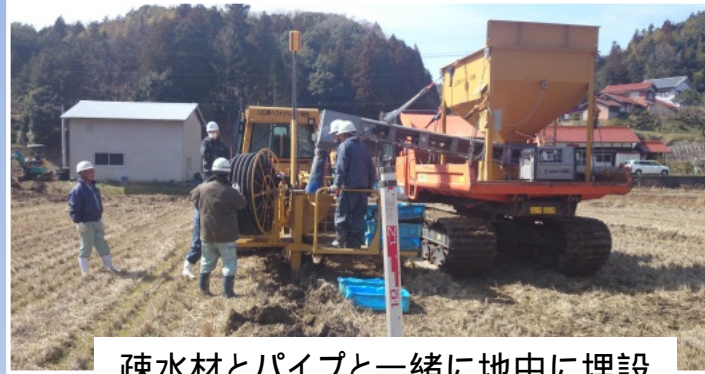
疎水材とパイプと一緒に地中に埋設
