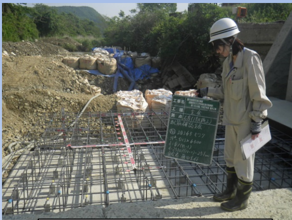
構造物の鉄筋の配置を確認
