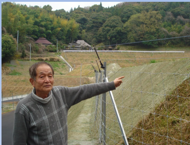
鳥獣侵入防止柵の整備
