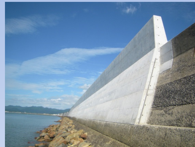
海岸保全施設整備事業 (堤防改修)
