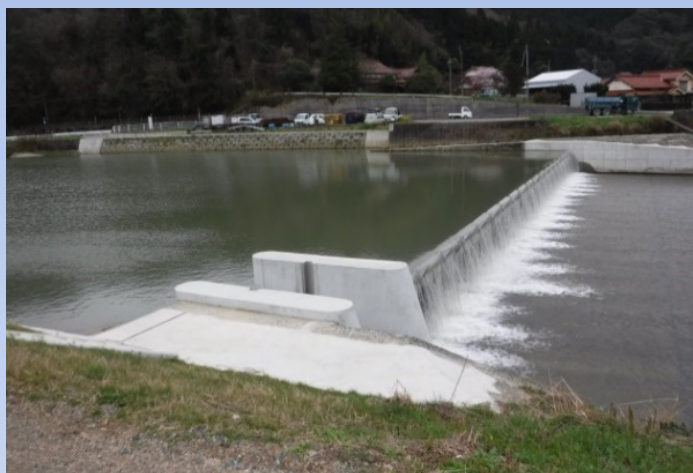
農村地域防災減災事業 (頭首工改修)
