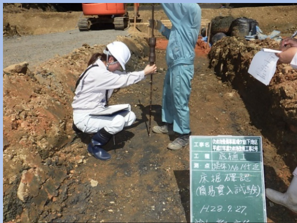
底樋の地盤を確認
