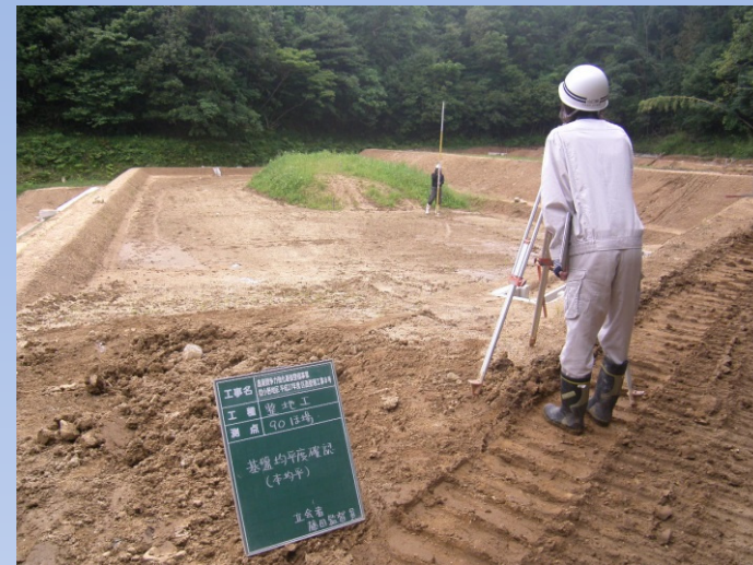
より良い農地になるよう工事の進捗を監督
