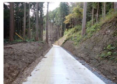
路網整備 (林業専用道)
