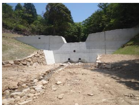
【治山ダムの整備】
