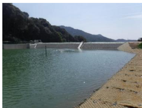
【ため池の改修】
