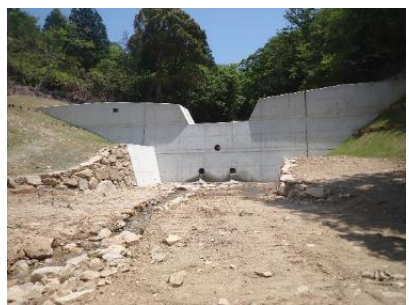
【治山ダムの整備】
