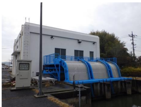
農業用排水機場の機能保全対策
