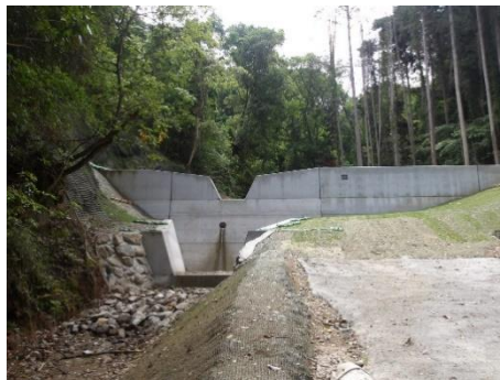
治山ダムの整備
