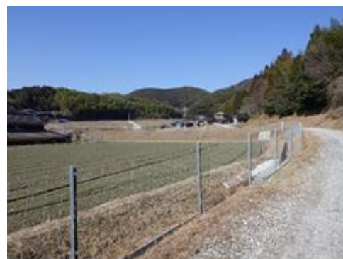
獣害防止柵の設置
