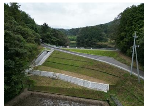
改修したため池
