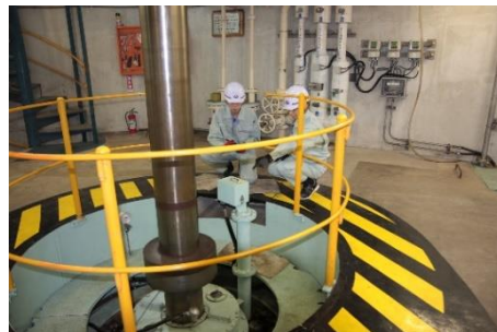
現場（徳山発電所）で水車の点検作業を行っているところ
